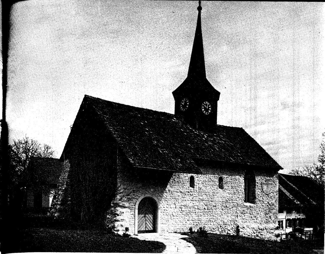
Nach der Restauration 1947/48. Vom Verputz entkleidet, Mauerwerk aus romanischer und gotischer Zeit freigelegt. Der romanische Türeingang wieder hergestellt, ebenso die beiden romanischen Rundbogenfensterchen, von denen nur das rechte original ist. Die Sonnenuhr mit dem Huggenbergerspruch.
