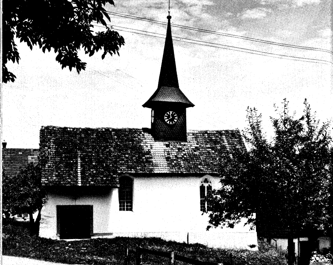
Georgskapelle vor der Restauration 1947/48. Diente nach 1874 bis 1946 als Feuerwehrlokal. Das hässliche Stichbogenfenster sollte mehr Helligkeit bringen. Das viereckige Tor wurde für die Feuerspritze ausgebrochen, das alte Mauerwerk verputzt.
